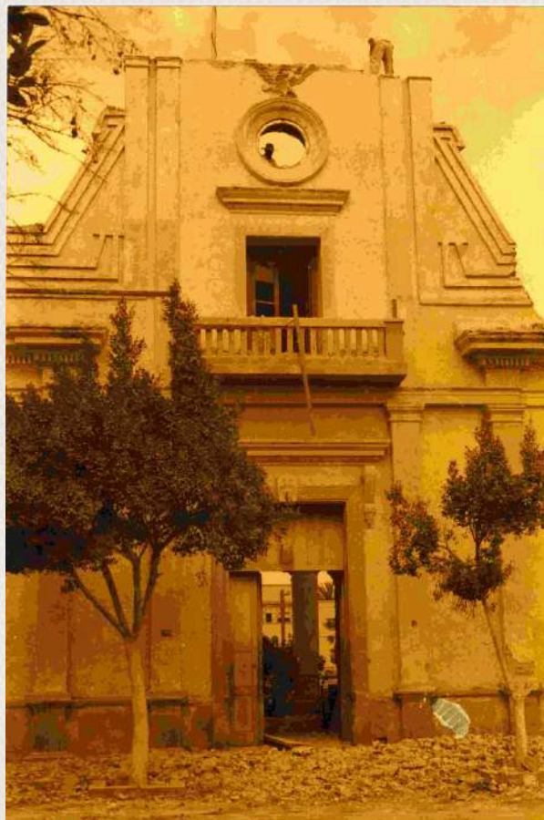
Casa de Gobierno, frontón en demolición
